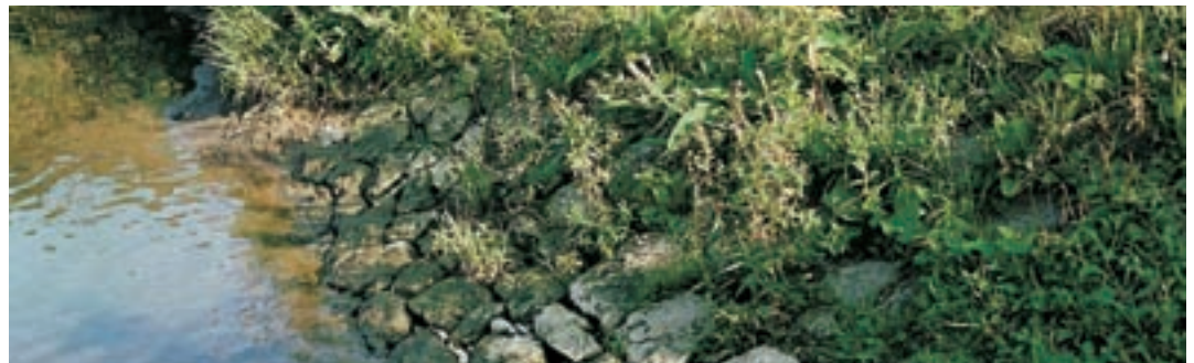
Bild rechts: Gepflastertes Mainufer vor 1996.
