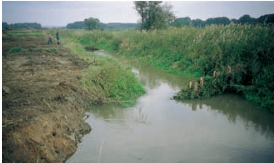
Abb. 21: Eine Buhne aus Totholz lenkt die Strömung ab und initiiert die Laufverlagerung (Gewässerentwicklung) durch Abtrag am Gegenufer.
