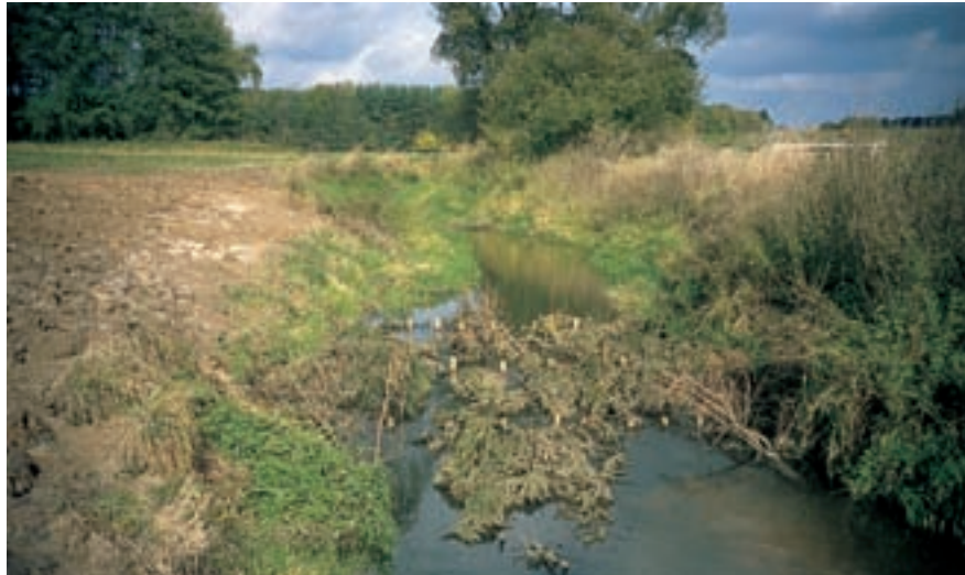
Abb. 19: Sohlenanhebung durch Einbau von Fichtenwipfeln.
