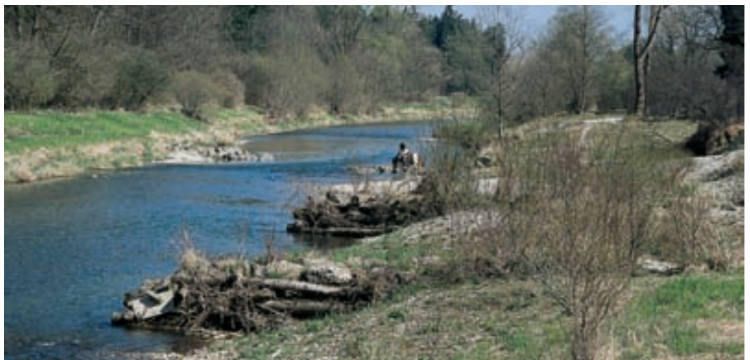
Holzkastenbuhnen, mit Steinen gesichert und mit Weidenstecklingen ausgefacht.
