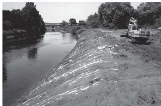
Bild rechts unten: Ufer wird abgeflacht.
