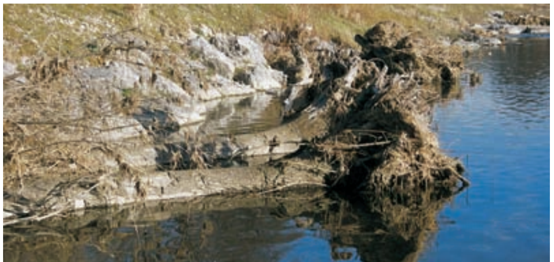
Stämme mit Wurzelstock, im Ufer eingegraben.
