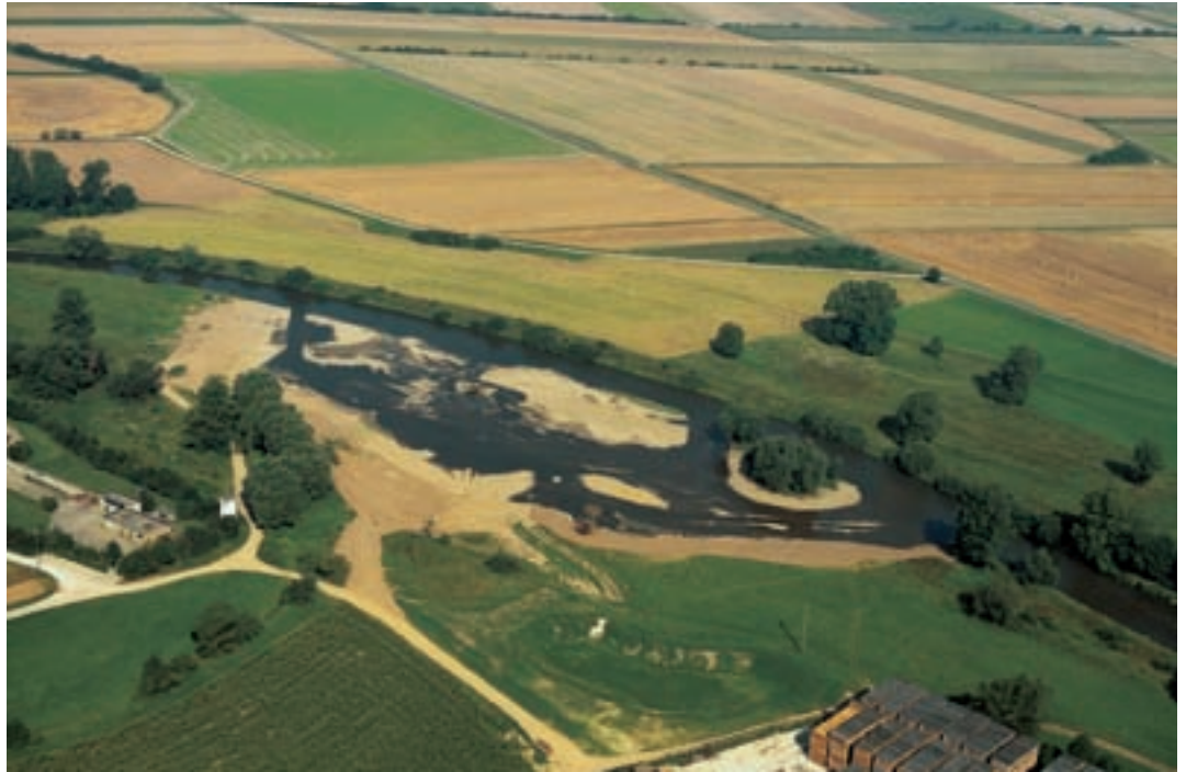
Umgestalteter Mainabschnitt bei Ebensfeld (1995).
