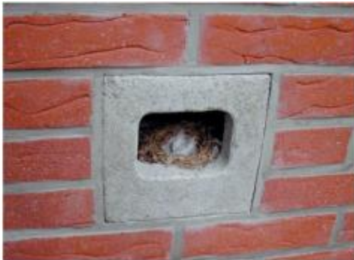
Abbildung 11: Niststein für Halbhöhlenbrüter (Bildquelle: https://www.nistkasten-hasselfeldt.de/Niststein-fuer-Halbhohlenbrueter/-Nischenbrueter )
