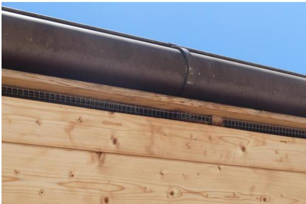
**Abb. B9:** wie B8 Rückgebäude Nr. 15. Drahtgitter verhindert stellenweise Einflug
